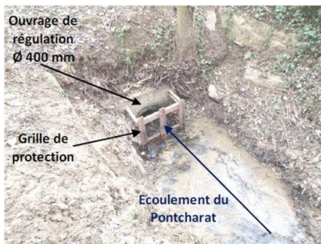
Ouvrage de régulation du Pontcharat (Buse Ø 400 mm) équipé d'une grille de protection
